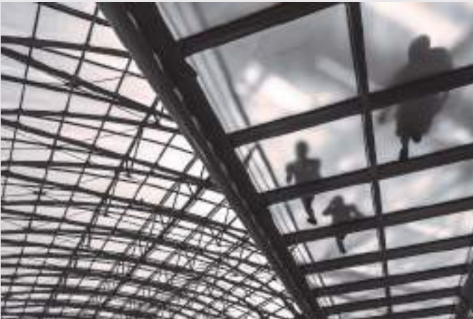
1. Leistungsklasse Kaufhauspassarelle, Alexander Paulus, Basel
